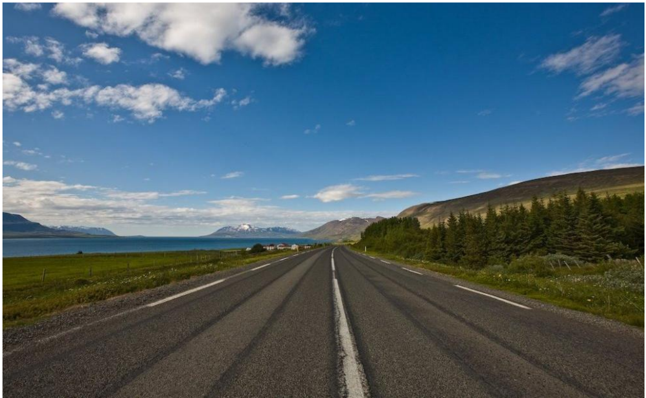
Mynd 21 Grenivíkurvegur til norðurs út Eyjafjörð
