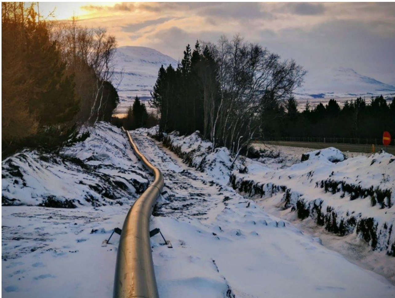
Mynd 23 Lagning hitaveitu um Vaðlareit úr Vaðlaheiðargöngum í Skógarböð
